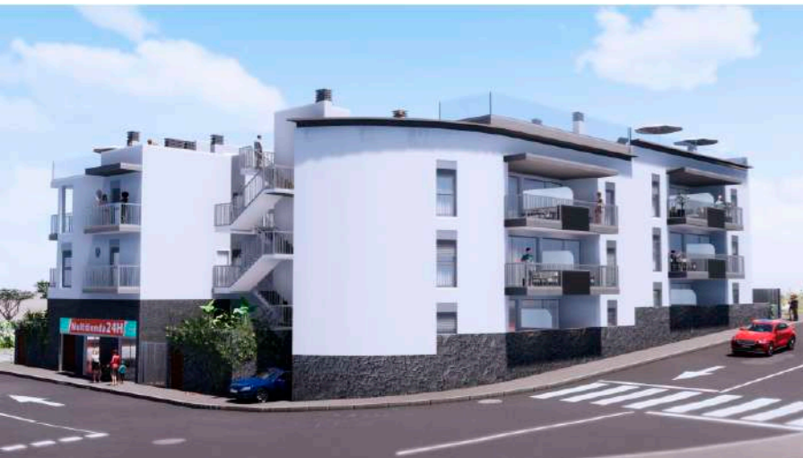
Situación del edificio en la Manzana
